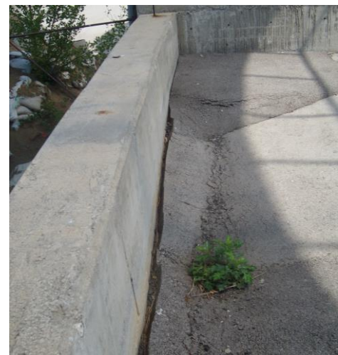
Слика 14.4-1. Слегање коловоза и пуцања асфалта на претоварној рампи и платформи ТС
