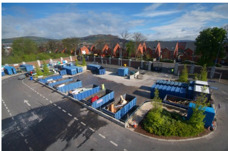
Слика 6.5. Изглед једног рециклажног дворишта
