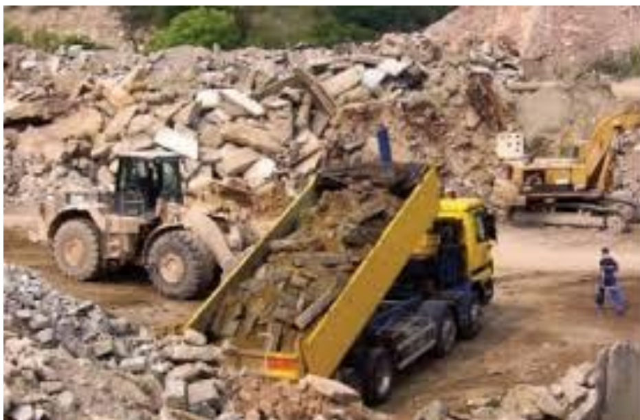
Слика бр.33: Грађевински отпад
