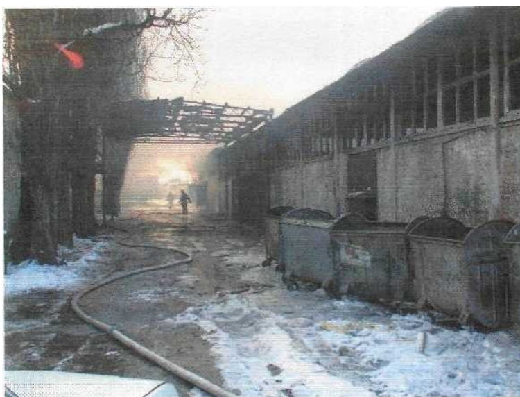
Магацин готових производа Предузећа "ЂУКАПОЛ", Ул. Војводе Степе бр. 310
