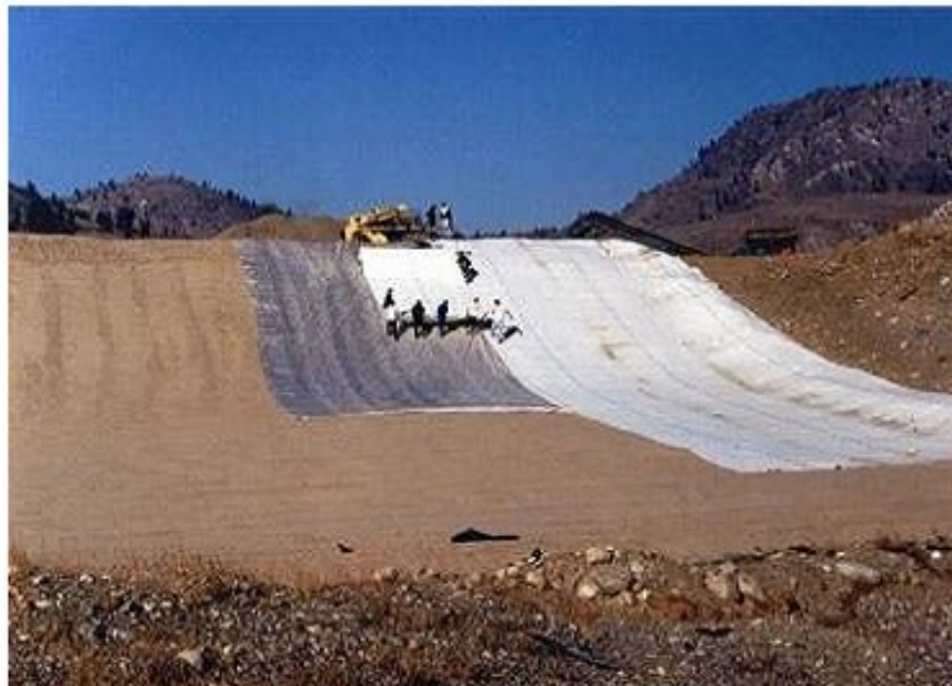
Слика – постављање доње непропусне фолије
