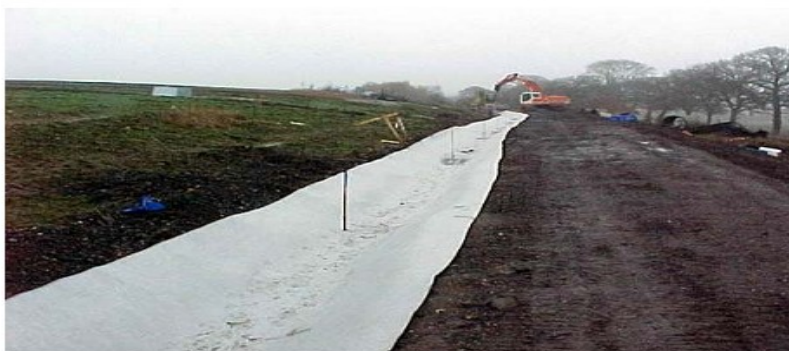
Слика – депонија са ободним каналима за отицање воде са фолије Потпуна ремедијација дивље депоније
