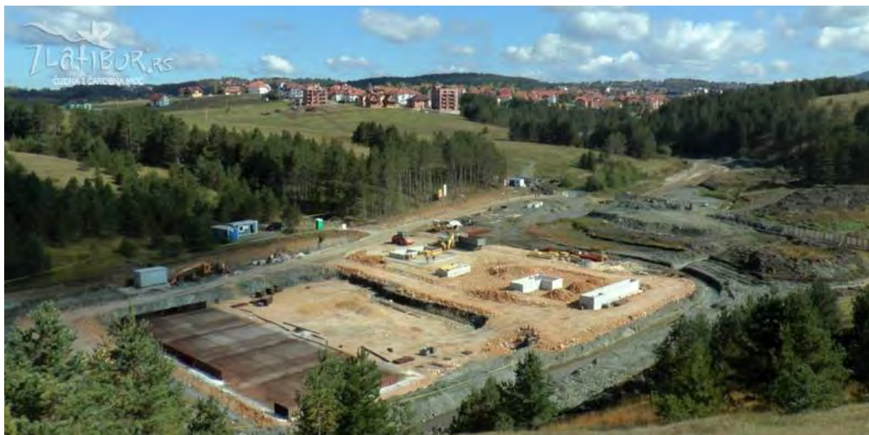
Радови на изградњи постројења за пречишћавање отпадних вода ЈКП Водовод „Златибор”
