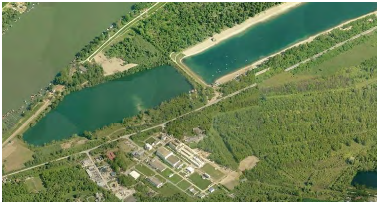
Река Сава, профил Макиш: Савско језеро - Постројење за пречишћавање воде за пиће „Макиш” Београдски водоводни систем
