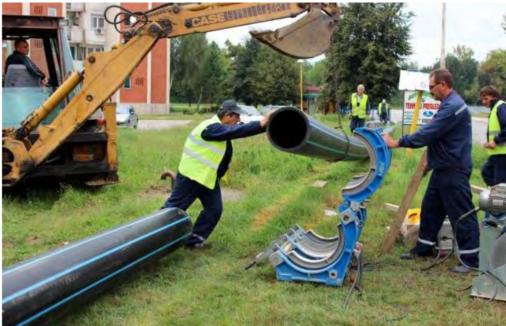
Реконструкција магистралног цевовода за водоснабдевање Јагодине (17.06.2015. Танјуг)
